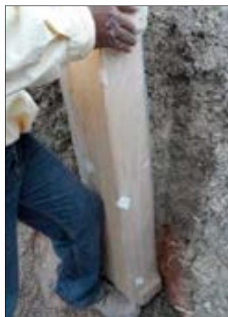
Figura 19: Colocación del cajón.
