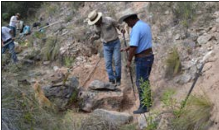
Figura 4. Las primeras piedras de la base del camellón.
